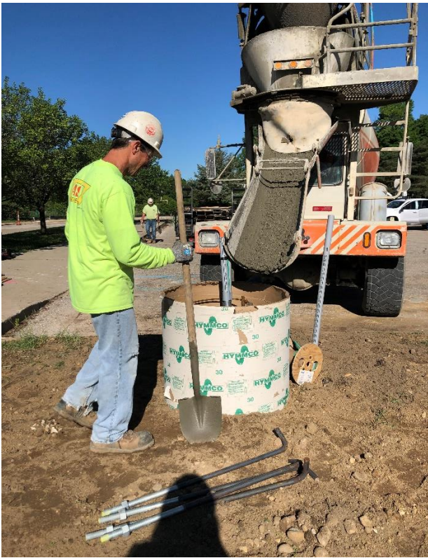
Pouring New Light Pole Base
